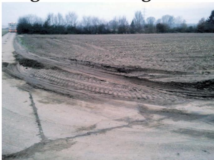
Das Bild zeigt den Zustand eines Feldweges in der Gemarkung Worfelden nach Befahrung mit schweren LKW
